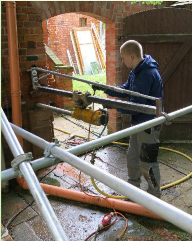
„Abnadeln“ des vom Einsturz bedrohten Giebels mittels ca. 12 m langen Edelstahlnadeln, die mit dem Mauerwerk verbunden werden.
